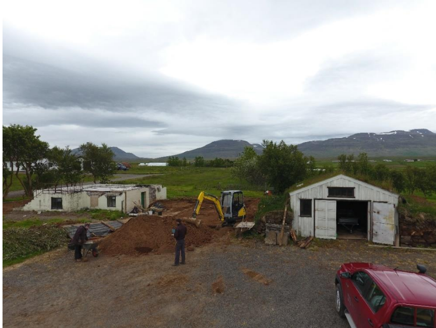
Geldingaholt í Skagafirði, torfbygging tekin niður og viðir færðir til varðveislu hjá Þjóðminjasafninu árið 2017 og fornleifarannsókn gerð á reitnum árið 2018 í samstarfi við Byggðasafn Skagfirðinga.
