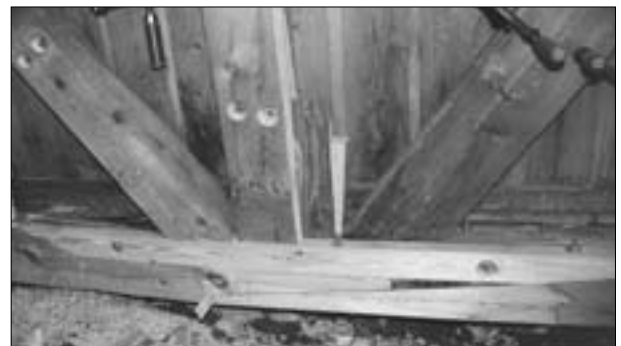
Gert við fótstykki, skástífu og stoð. Fúinn viður er höggvinn í burtu og nýtt efni fellt inn og fest með lími og skrúfum. Hálskirkja í Fnjóskadal.
