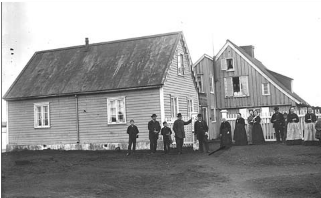
Húsið og Assistentahúsið á Eyrarbakka. Húsið er innflutt danskt timburhús byggt 1765 og eitt elsta timburhús landsins. Assistentahúsið er byggt um 1880. Húsið er klætt reisisúð en Assistentahúsið liggjandi plægðri og strikaðri vatnasklæðningu. Myndin er tekin 1884 eða 1886. Ljósmynd Sigfús Eymundsson. Þjóðminjasafn Íslands.
