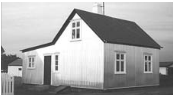
Einfalt bárujárnshús. Akbraut, Eyrarbakka.
