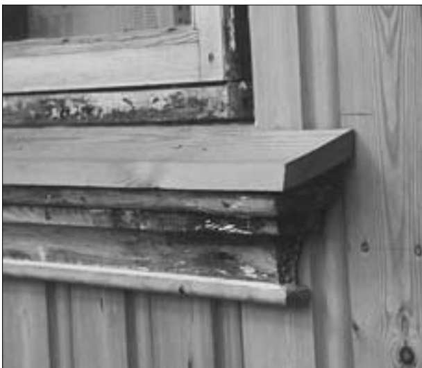
Listi undir vatnsbretti endurnotaður. Eftir er að setja upp gluggafalda.
