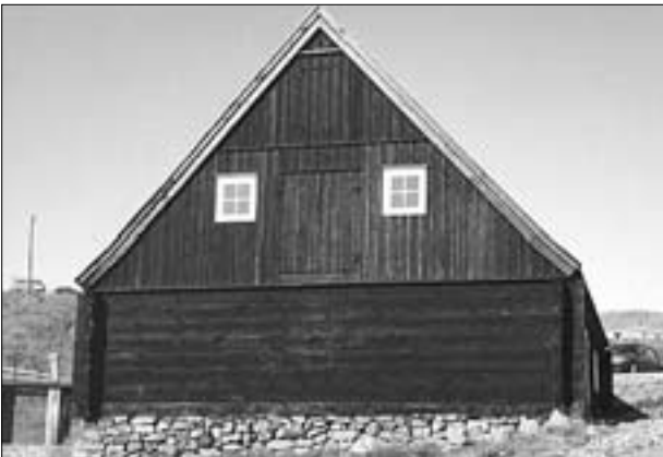
Pakkhúsið á Hofsósi, danskt stokkhús sem kom tilsníðið til landsins og var reist 1777. Gaflinn er klæddur reisiföl.
