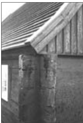
Stokkverk. Pakkhúsið á Hofsósi.
