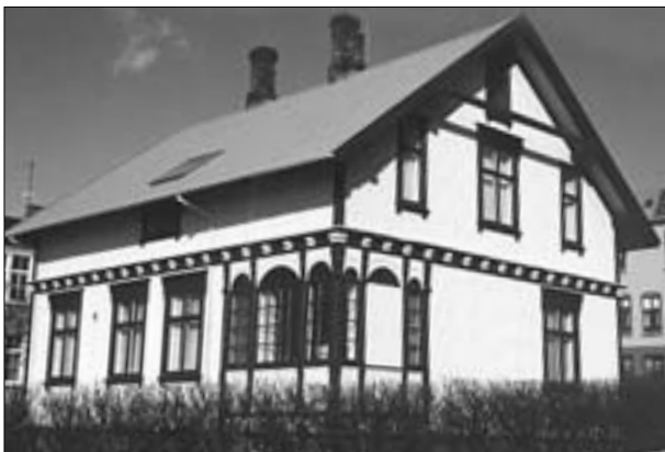
Bárujárnssveitser. Frikirkjuvegur 3, Reykjavík, byggt 1905.
