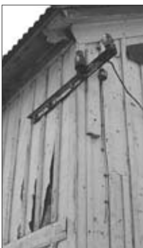
Útveggjaklæðning úr máluðum pappa með listum. Líkist listasúð. Sjópakkhúsið í Stykkishólmi.
