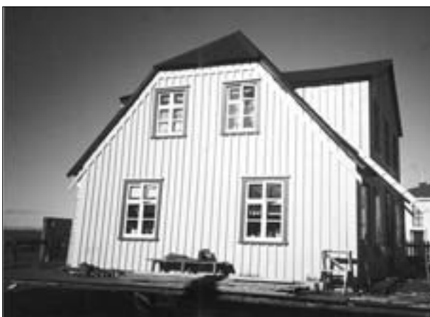
Kúldshús í Stykkishólmi, haustið 1997. Búið er að klæða suðurgaflinn, en vindskeiðar vantar.
