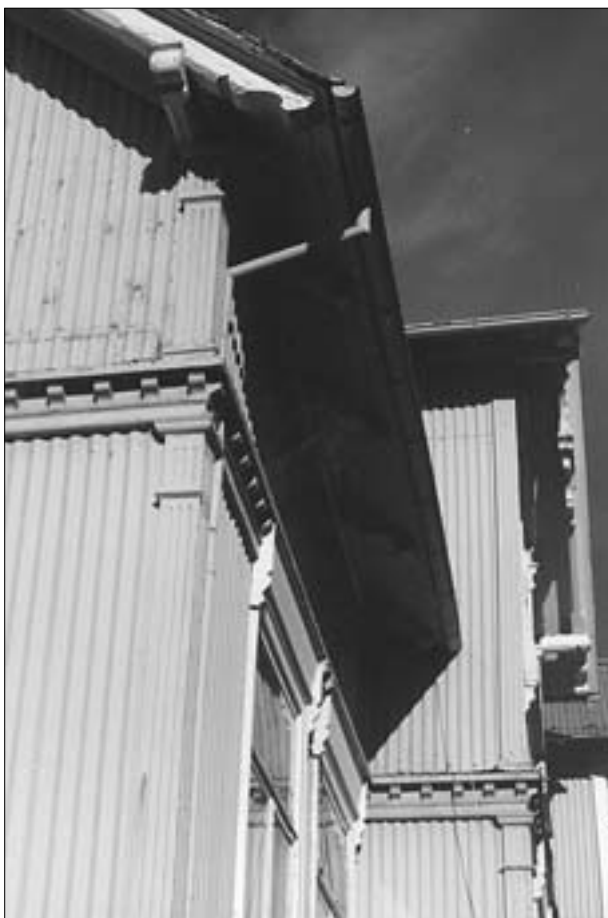
Sveitserstílhús með skreytta hornstokka og vatnsbretti milli hæða. Á sveitserstílhúsum er algengt að vatnsbrettið undir eða yfir gluggum gangi umhverfis allt húsið og myndi band eftir húshliðinni. Vatnsbrettið getur verið sett á krappa, skreytt borð eða bjálkaendarnir á efri hæðinni látnir stingast út úr veggnum og vatnsbrettið síðan lagt ofan á þá. Viðgerðir eða endurbætur á vatnsbretti milli hæða fara fram á sama hátt og á vatnsbretti við sökkul. Gæta þarf þess að loka ekki fyrir loftun á bak við bárujárnið.
