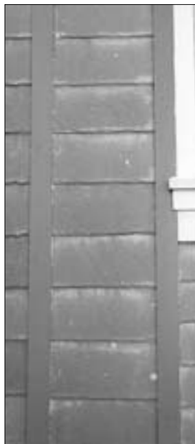
Útveggir klæddir steinskífu með listum yfir lóðrétt samskeyti. Kirkjutorg 6, Reykjavík.
