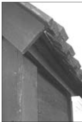
Bolverk. Þingholtsstræti 9, Reykjavík, byggt 1846. Nú í Árbæjarsafni. Stokkar langhliða eru óklæddir en stafnar eru klæddir reisisúð.
