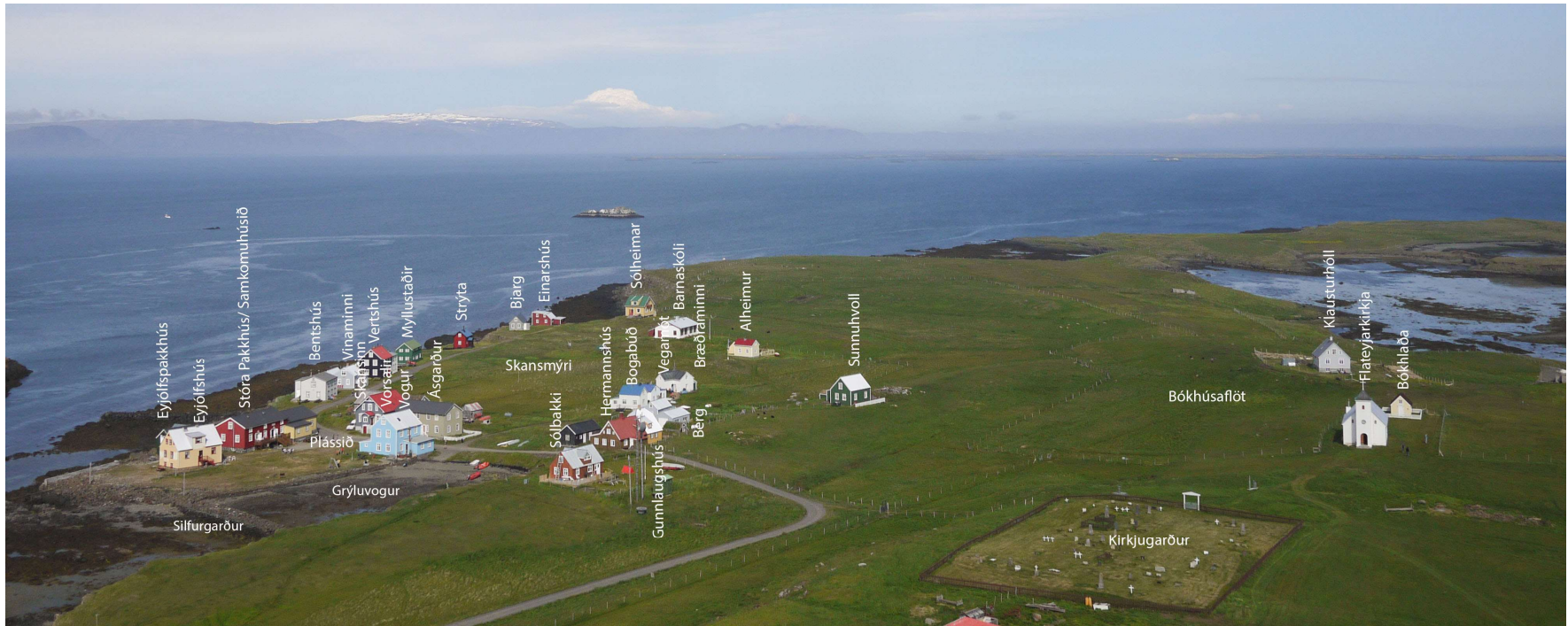
Mynd 7. Þéttbýlið í Flatey og byggingar á Bókhúsaflöt
