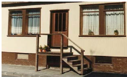
Mynd 4 Hér hafa rammar verið fjarlægðir úr gluggum og ný útidyrhurð og tröppur gerðar við húsið.
