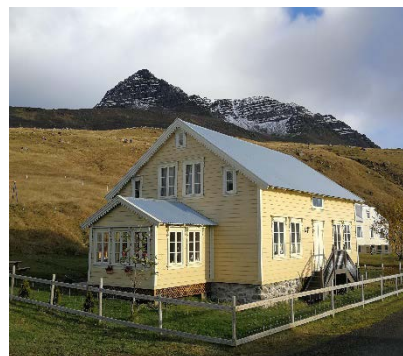
Sandhús í Mjóafirði. Byggingarár: 1884-86. Myndin til vinstri er tekin árið 2009.
