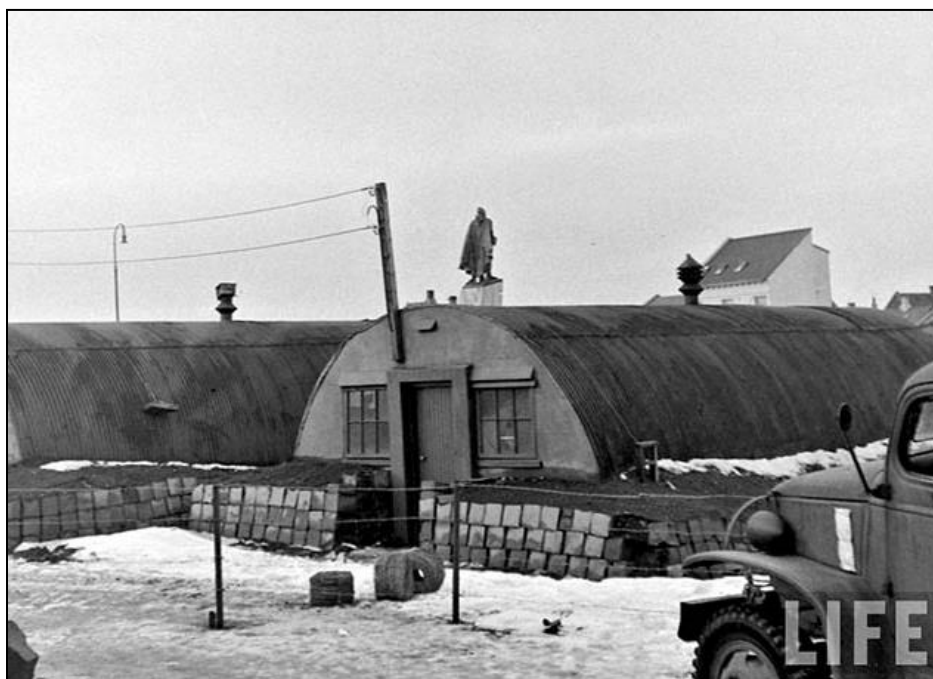
Samskonar braggi með hlöðnum og pússuðum göflum og styrktarhleðslu úr blikkbrúsum undan bensíni og jarðvegsfyllingu á Skólavörðuholti. Bresku braggarnir höfðu jafnan ekki lofttúður á þaki. Einungis reykrör frá hitunarofni eins og hér sést en loftræstiristar á göflum.
