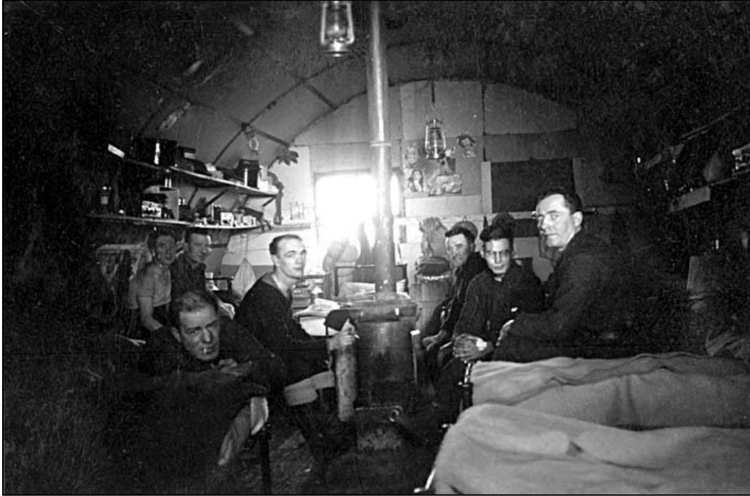
Breskir sjóliðar í íbúðarbragga á Hálsnesi í Kjós. Einn ofn var til upphitunar og brenndi kolum og koxi í hlutfallinu 1:3. Opnanlegir gluggar voru á báðum göflum bragganna auk loftræstiristar ofan við hurð á framgafli. Bretar höfðu svefnpoka en þurftu að smíða sér eigin rúm úr tilfallandi efni svo sem kassafjöllum.
