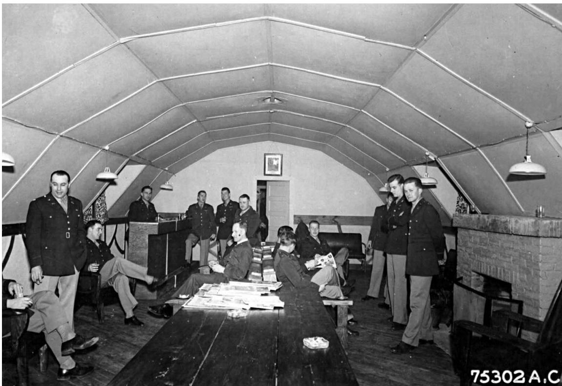
Setustofa bandarískra liðsforingja í 20 feta breiðum portbyggðum bragga af gerðinni „Re-designed Quonset“ með oddmynduðum mæni. Sú stærð gekk jafnan undir heitinu J.B. Quonset.
