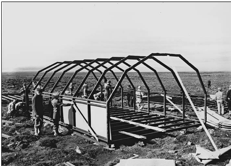
Portbyggður braggi af endurbættri Quonset-gerð í smíðum á Keflavíkurflugvelli.
