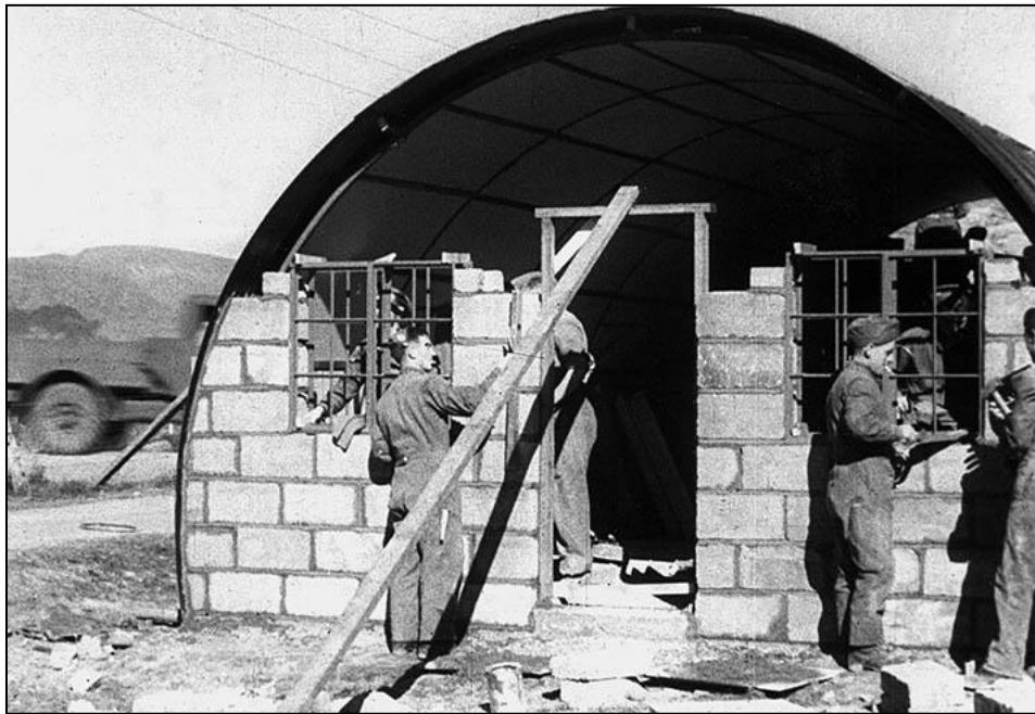
Gaflar minni bresku Nissen-bragganna voru ýmist úr timbri eða hleðslusteini og oftast múrhúðaðir. Vel sést hvernig hliðarnar hvelfast inn við gólf braggans til þess að auka nýtingu gólfrymis með hliðum.
