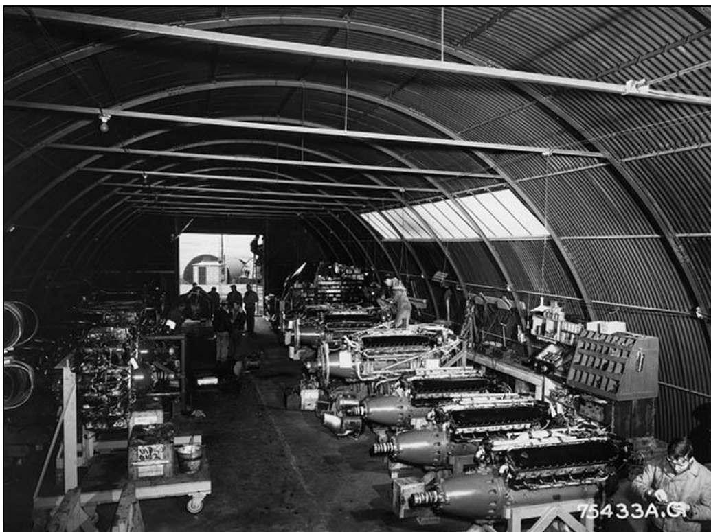
Flugvéla verkstæði Bandaríkjahers á Reykjavíkurflugvelli í breskum 35x95 feta bragga með T-laga stálboga og ísettum gluggum á hlið.
