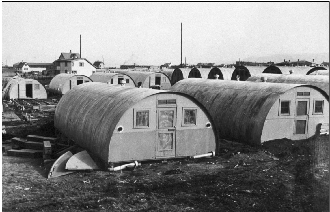
Quonset T-rib braggar í smíðum í Camp Knox í Reykjavík vorið 1942. Bandarískir braggar höfðu lofttúður á þaki auk reykroörs frá kolaofni sem hafður var til kyndingar.
