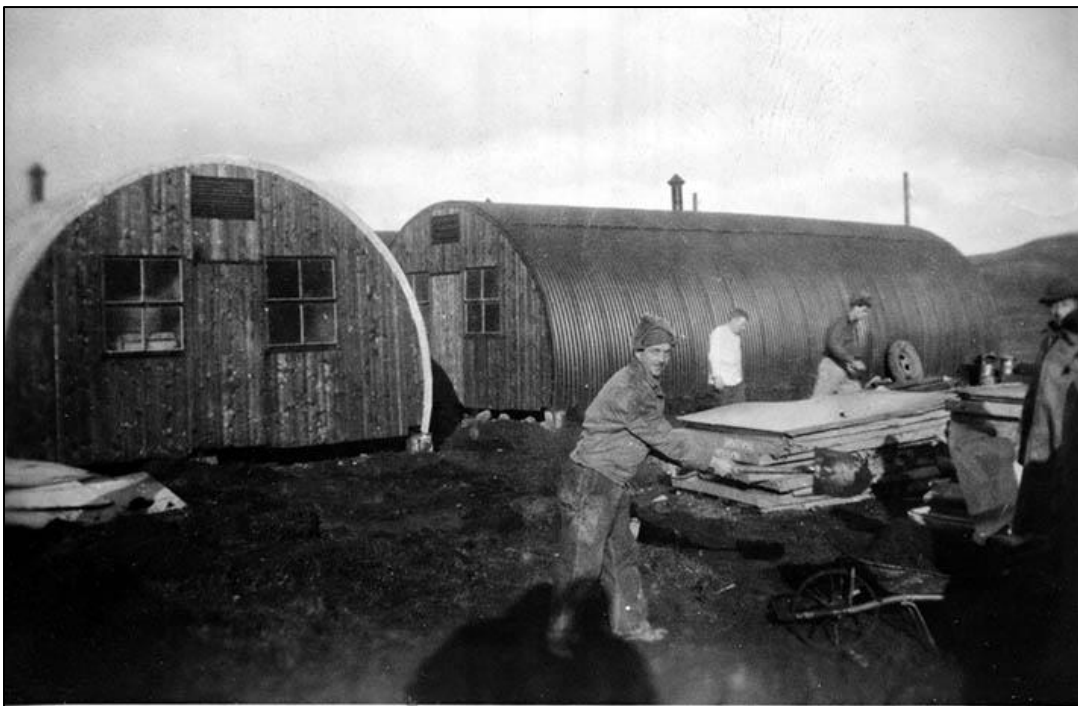
Breskir Nissen-braggar með loftræstirist á gafli og reykörör frá kolaofni sem notaður var til kyndingar.
