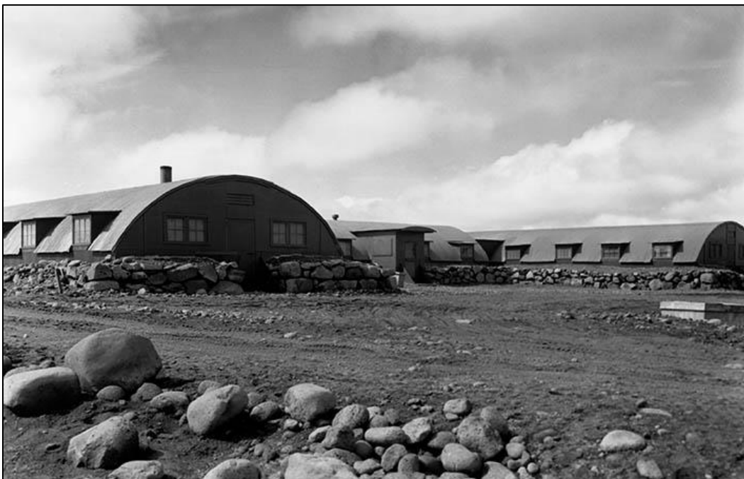
24 feta breiðir Redesigned Quonset-braggar með kvistgluggum við Keflavíkurflugvöll.
