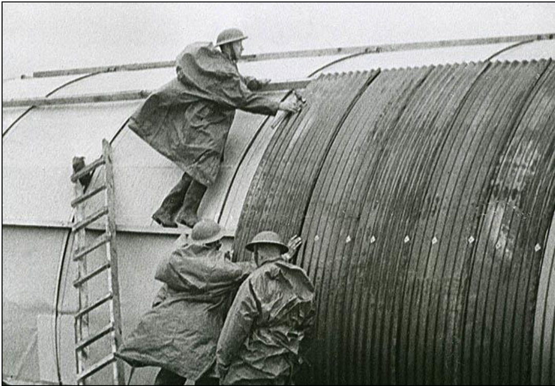
Bandarískir landgönguliðar reisa Nissen-bragga. Bárujárnið er neglt á langbönd úr tré. Bresku braggarnir voru án einangrunar með innra byrgði úr trétexi.
