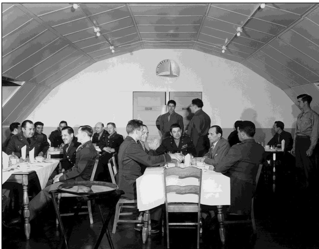
Veitingasalur flugvallarhótelsins á Keflavíkurflugvelli, Hotel De Gink, í 24 feta breiðum „Re-designed Quonset“-bragga með láréttri bogaeiningu í mæni.
