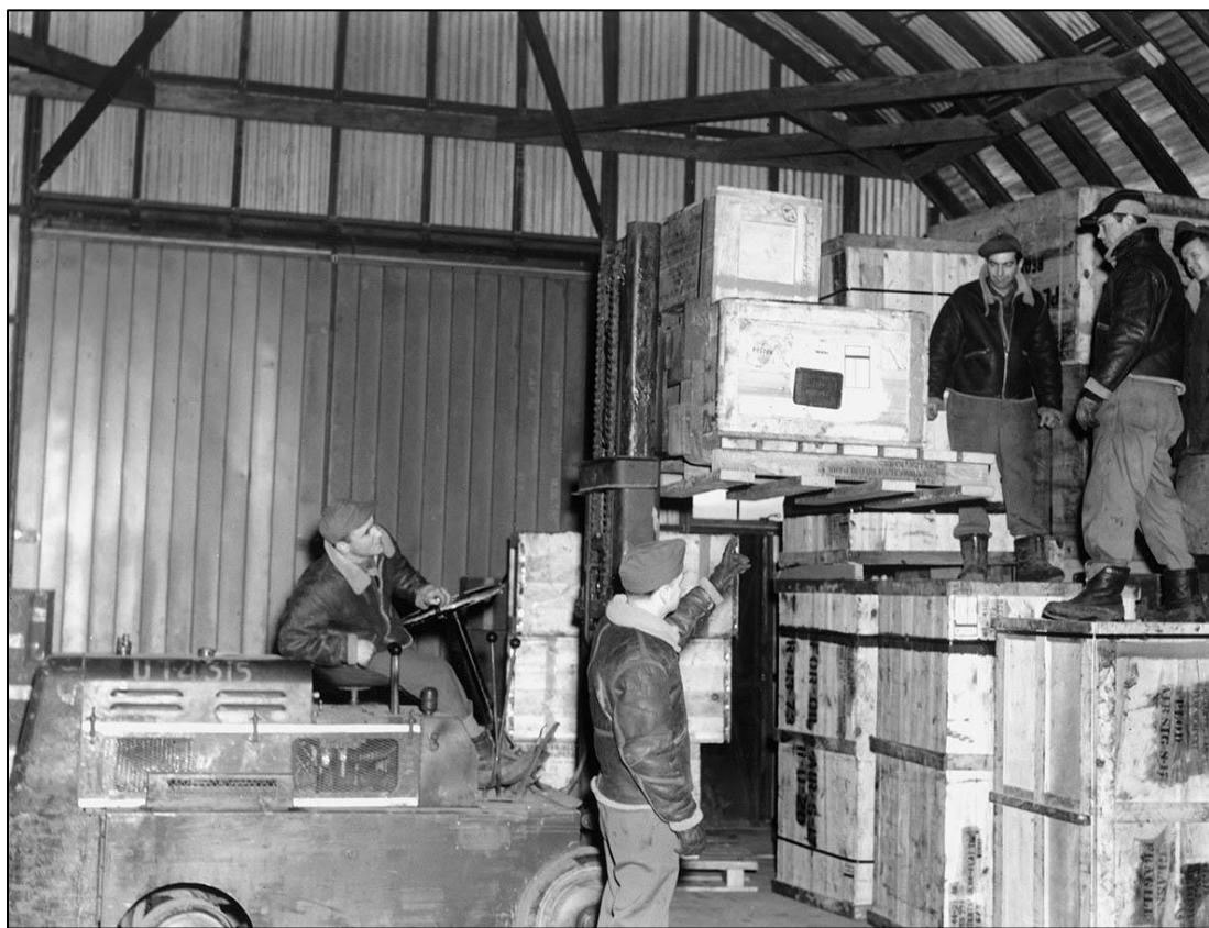
Liðsmenn flughersins að störfum í birgðaskemmu af gerðinni Stran Steel. Gaflinn hefur verið styrktur með timburgrind í hornum.
