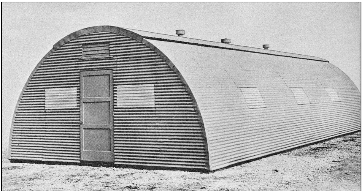
Endanleg gerð Quonset-bragga frá Stran-Steel með liggjandi bárujárnsklæðningu og báruðum trefjaglersplötum í stað glugga eins og reistir voru á Keflavíkurflugvelli haustið 1951. Stórar birgðaskemmur af Quonset-gerð voru með sama útliti frá upphafi en ekki með trefjaglersplötum.
