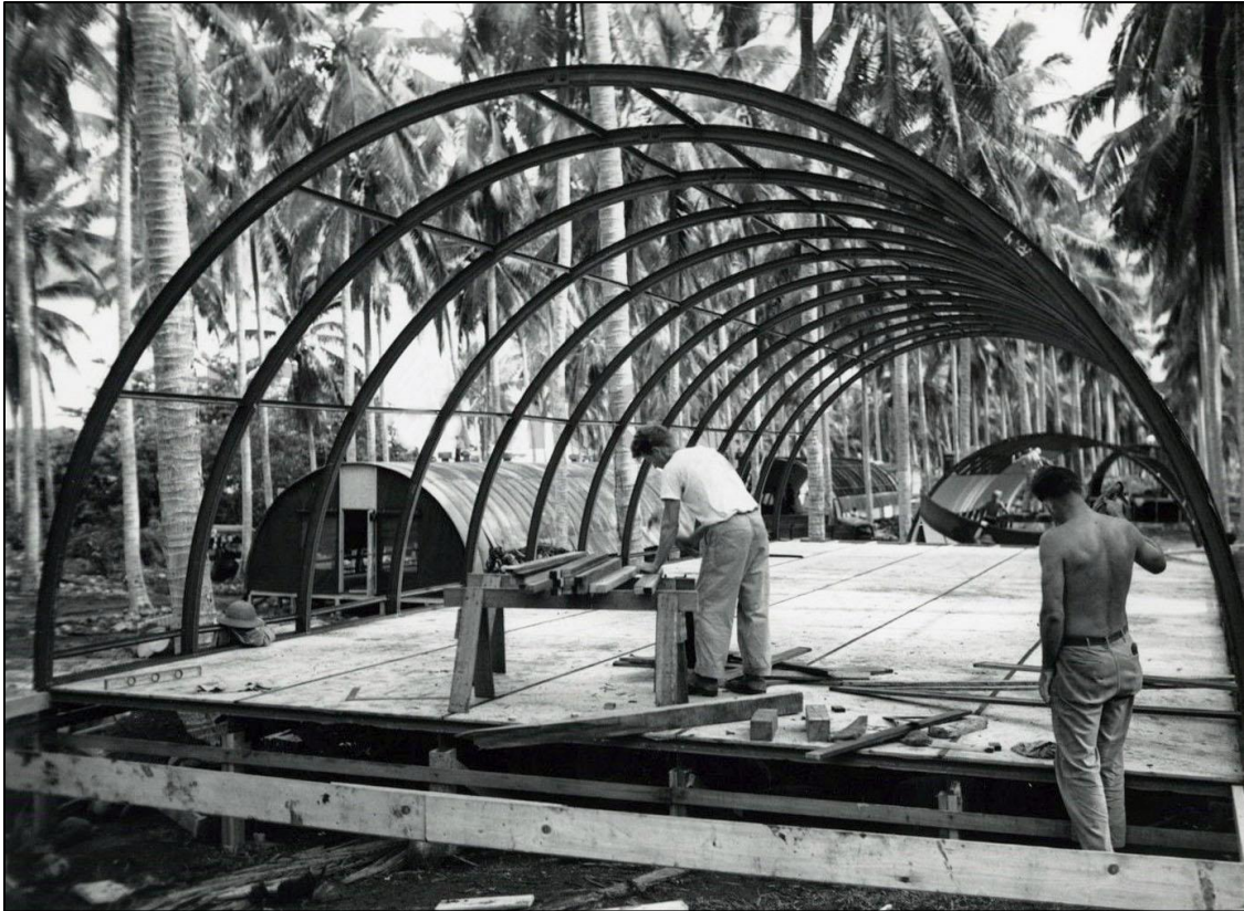
Bandarískir landgönguliðar reisa 20 feta Quonset-bragga frá Stran-Steel með heilum burðarbogum, langböndum og standandi bárujárnsklæðningu á eyju í Suður-Kyrrahafi. Þessi gerð barst ekki til Íslands.
