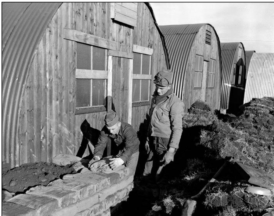
Bandarískir hermenn hlaða sandpokum að Nissen-bragga til styrktar. Fyllt er upp að bárujárnsklæðningunni með mól og tyrft yfir. Braggarnir eru með hefðbundnum timburklæddum göflum og hrufóttu og vírbundnu „Bretagleri“ í tilbúnum pottjárnsgluggum með opnanlegum fögum.
