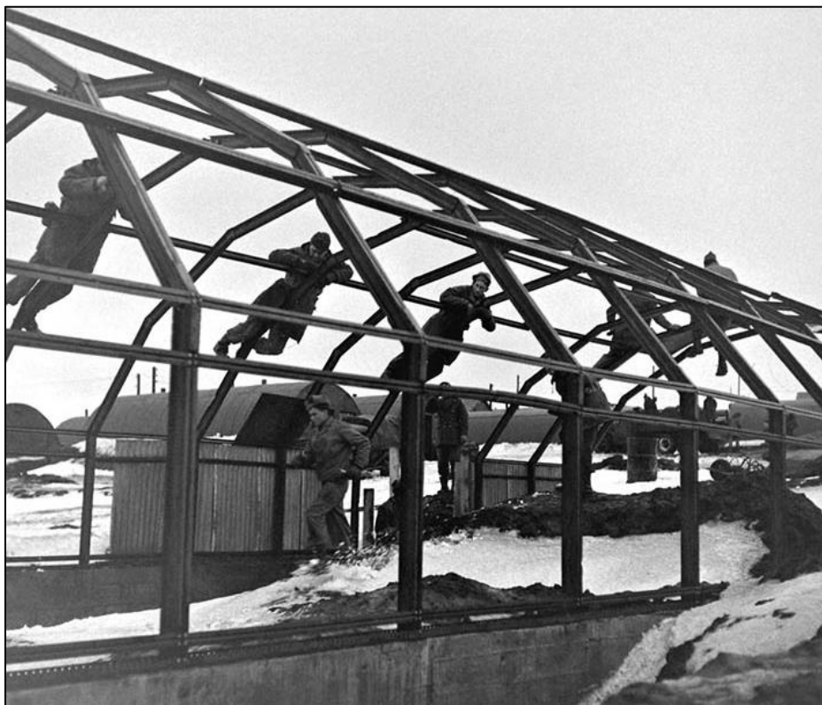
Bandarískir hermenn reisa kantaða burðargrind Quonset-bragga af endurbættri gerð á steinsteyptum grunnni sem gaf aukna lofthæð.
