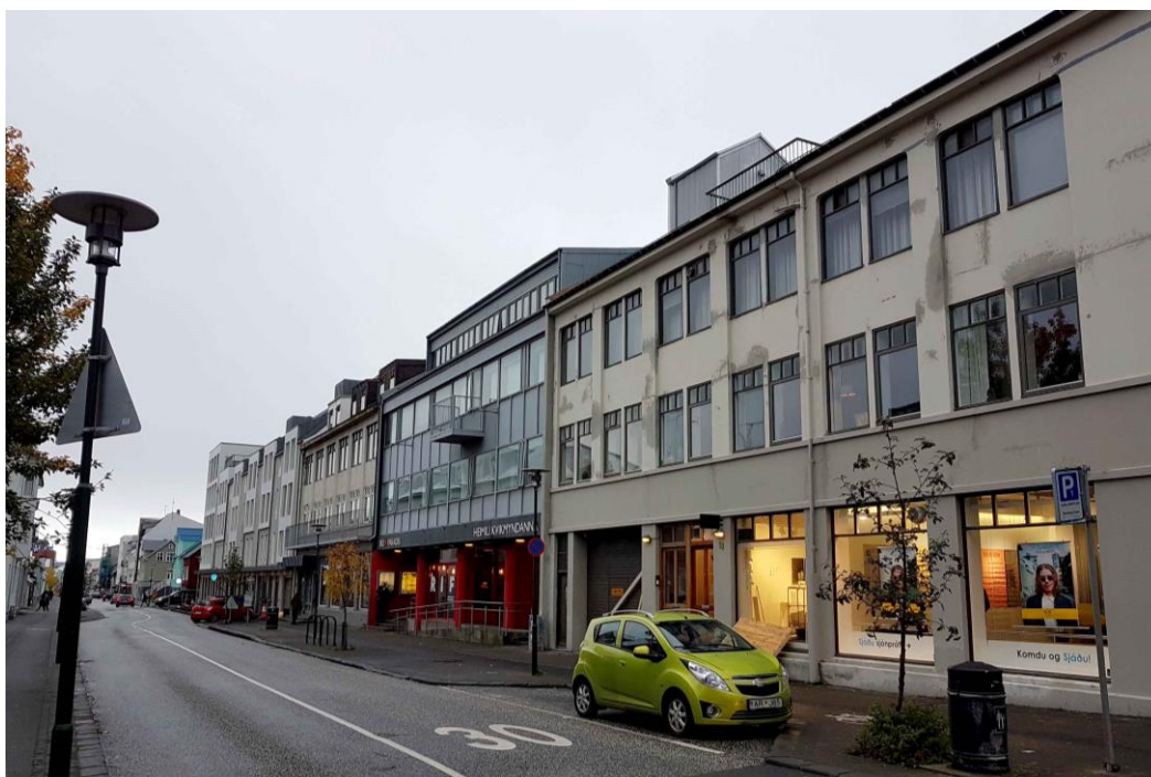
Götumynd Hverfisgötu á þeim kafla þar sem húsið stendur (milli Vatnsstígs og Frakkastígs). 9
