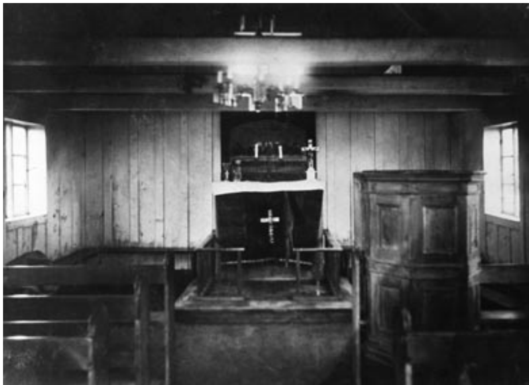
3. Innan úr Miðgarðakirkju árið 1902. Ljósmyndari Eiríkur Þorbergsson. Í vörslu kirkjunnar. — Interior of Miðgarðar Church, 1902. Photo Eiríkur Þorbergsson.
