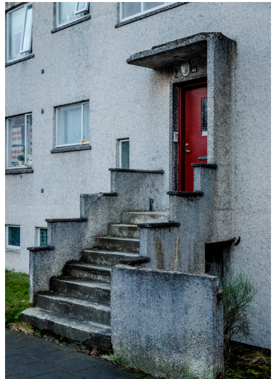
MYND 17 Tröppur upp að inngangi með umgjörð og skyggni með sömu áferð og útveggir.
