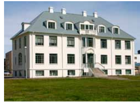
Safnahúsið. Gamla sjúkrahúsið, Ísafirði
