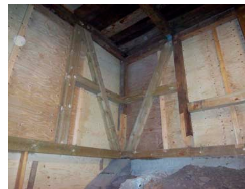
Faktorshúsið Djúpavogi, lagfæringar á grind
