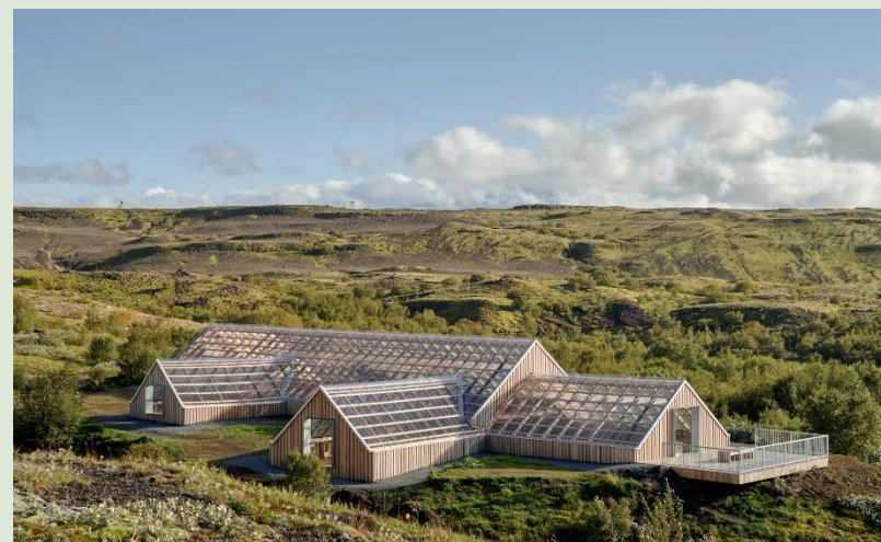
Mynd 2-11. Ný yfirbygging á Stöng í Þjórsárdal eftir SP(R)INT STUDIO.
