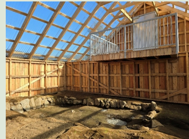
Mynd 13: Bygging sem kom í ljós við fornleifarannsókn árið 2023, austan við skálarústina. Ákveðið var að varðveita hana með skálanum.
