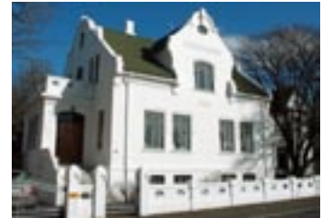
Laufásvegur 7, Prúðvangur, Reykjavík
