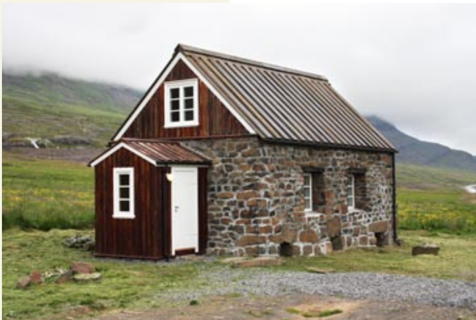
Sómastaðir að lokinni viðgerð sumarið 2010
