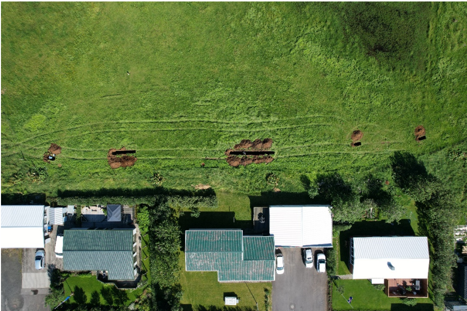
Mynd 43. Yfirlitsmynd af könnunarskurðum sem gerðir voru vegna fyrirhugaðra gatnaframkvæmda við Hjalladæl á Eyrarbakka. Ljósmynd: Atli Rúnarsson.
