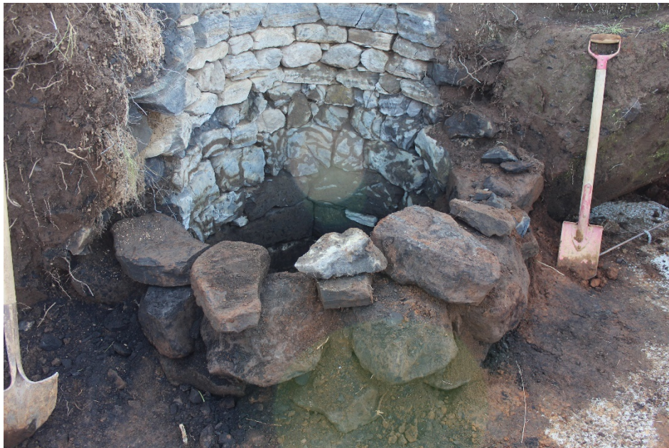
Viðgerð á strompi friðlýsts hellis á Ægissíðu, Rangárþingi ytra.
