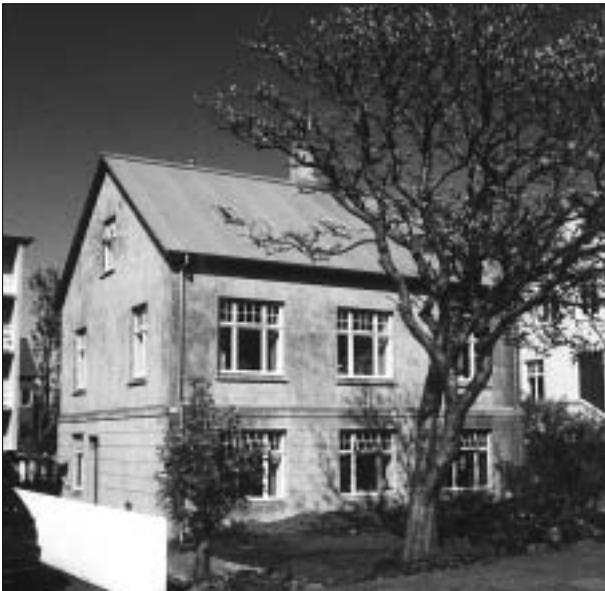
94 Í byrjun voru steinsteypt hús sléttþússuð að utan og ómáluð eins og þetta hús við Öldugötu.
