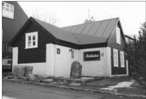
37 Steinbærinn Stöðlakot við Bókhöfundustíg.
