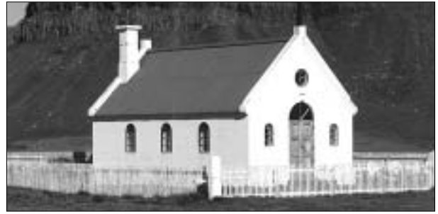
133 Sæbólaskirkja á Ingjaldssandi, byggð 1923.
