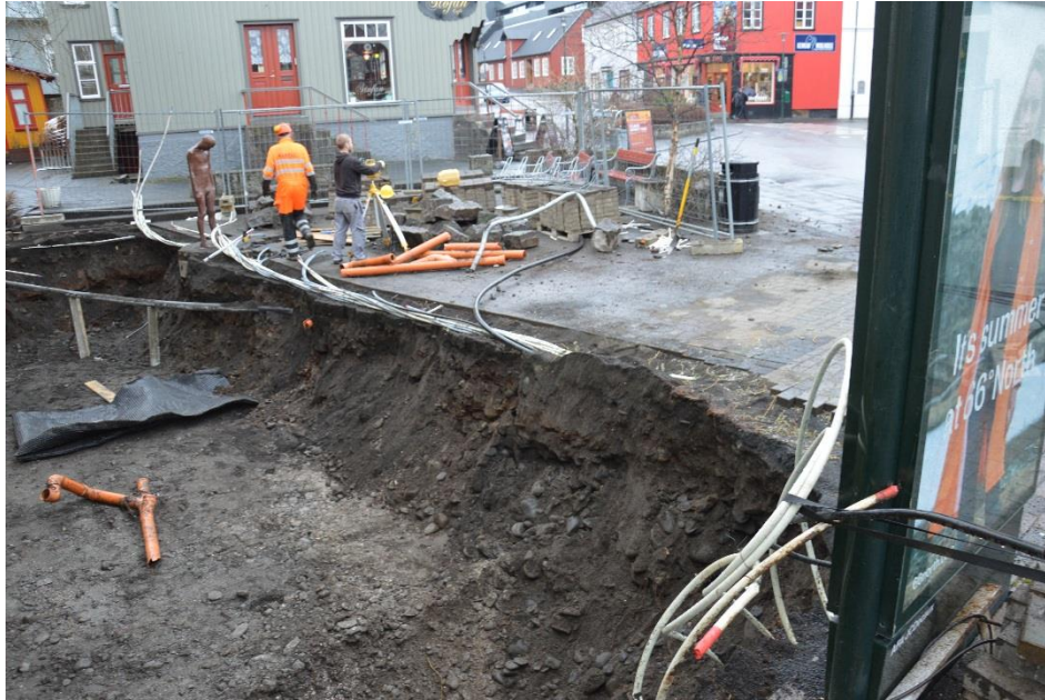
Mynd 8. Aðalstræti 2 í Reykjavík. Framkvæmdasvæðið að lokinni rannsókn. Horft í norðvestur. Ljósmynd: Nicola Trbojevic.
