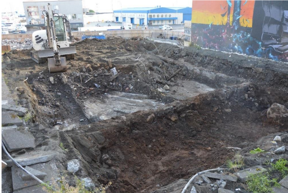
Mynd 7. Vesturgata 18 í Reykjavík, framkvæmdasvæðið. Horft til norðausturs. Ljósmynd: Nikola Trbojevic.
